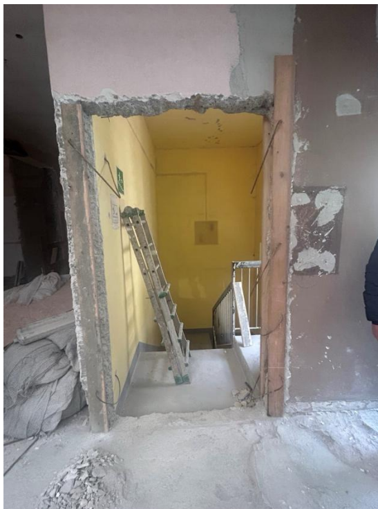
Fig. 1: Apertura del varco blocco scala sud
